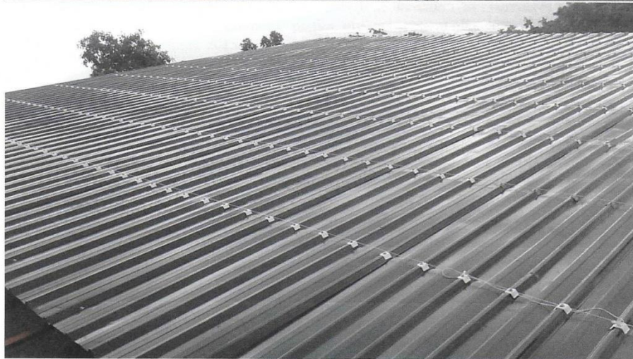
Photo Réhabilitation du Toit de l'ECGBV
