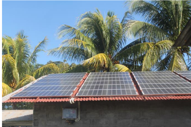
Figure 5 - Equipement photovoltaïque de l'hôpital de Gros Morne- financement EDF à la demande du CEFREPADE
